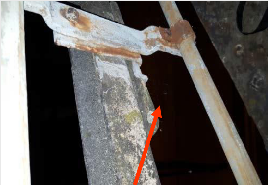
Cement packers beneath cement conduit
